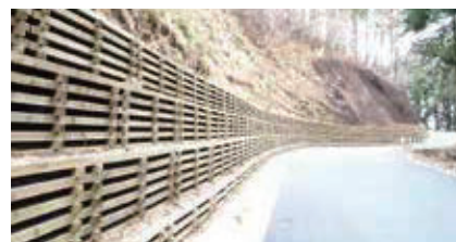
「高耐久木製柵」を使用した土留工
