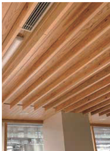
某公共施設の天井ルーバー
