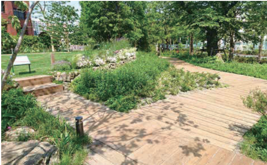
ガーデン枕木を埋設
