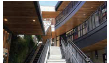
某商業施設の軒天
