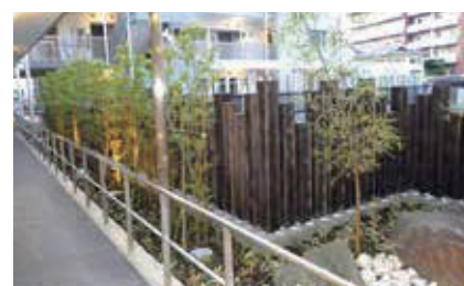
削孔支柱ピン工法による木柵
