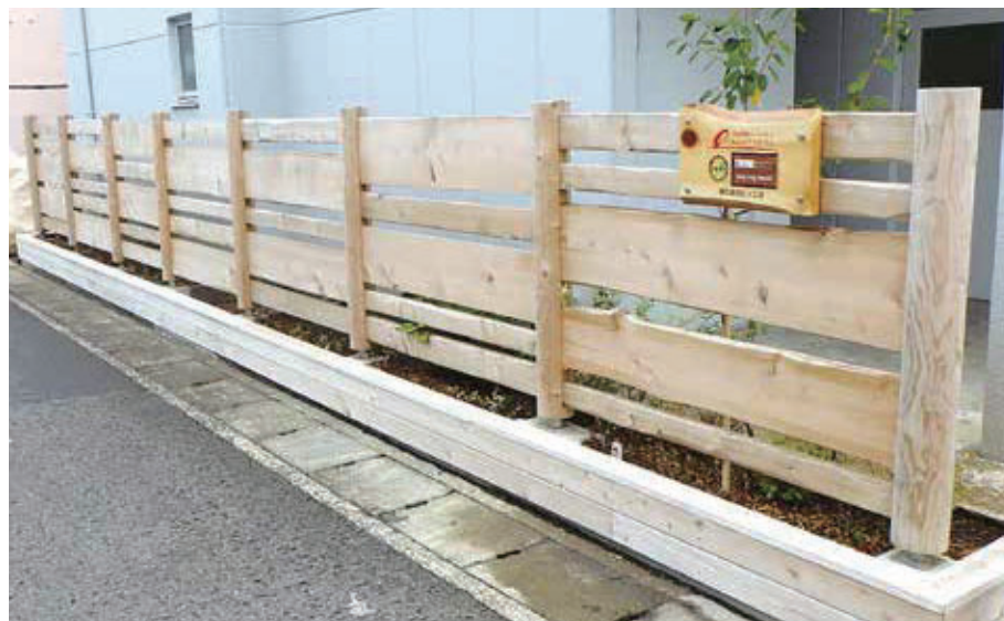
削孔支柱ピン工法による木堀
