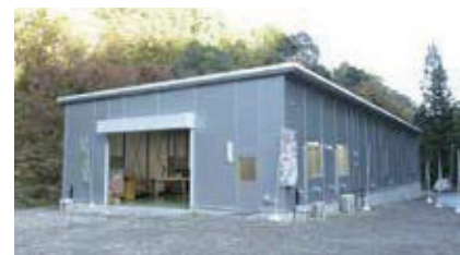
檜原村で稼働する新工場
