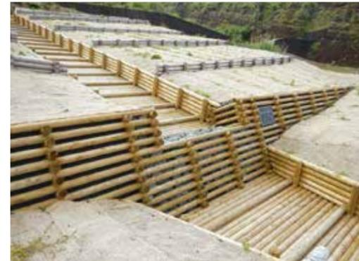
災害復旧を図るための土留め等に、高耐久の加工を施した東京の木 多摩産材を使用しています。(三宅村)
